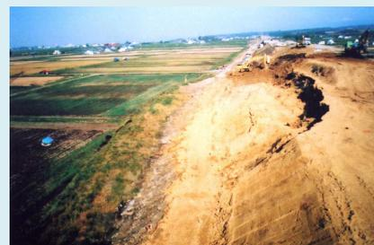
盛土による泥炭地盤の破壊
