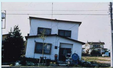
沈下による家屋の傾き
