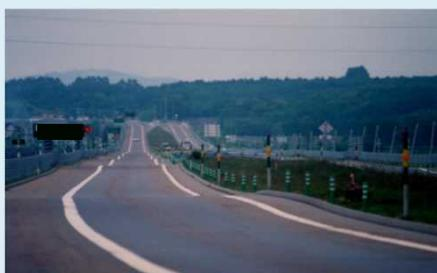
沈下による道路の凸凹
