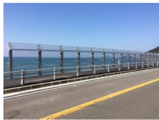
平成27年度 国道202号 佐賀県 唐津市
