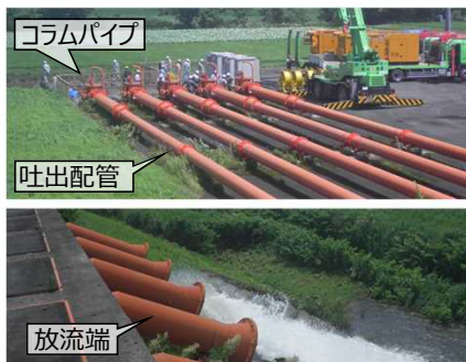
図-1 救急排水機場外観
