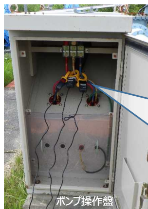
図-6 センサー設置例
