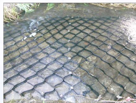
ネットを軟岩河床にアンカーを用いて設置する。
