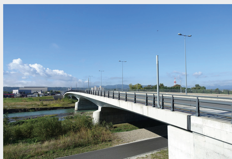
青緑みのグレー 5BG5/1 照明柱; 旭川市 北彩都地区クリスタル橋
