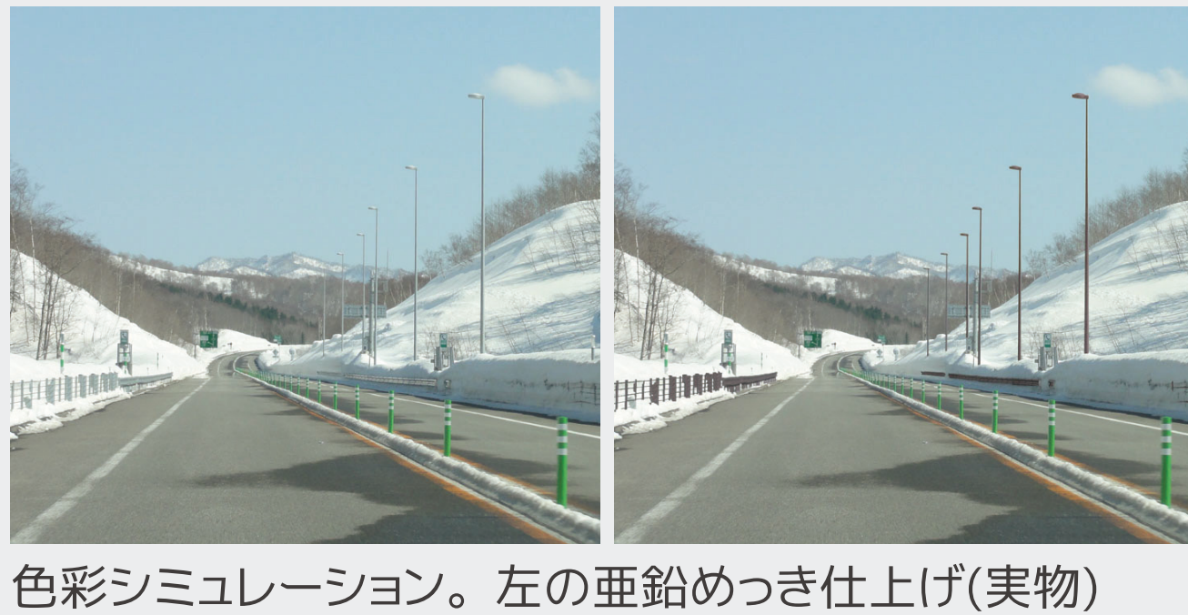
色彩シミュレーション。左の垂鉛めっき仕上げ(実物)よりも、右のこげ茶系の色彩(フォトモンタージュ)のほうが、照明柱や防護柵が目立って見える。
