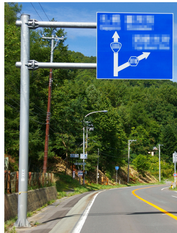
▲一般的な片持式(F型柱)案内標識(敷地に余裕がない場合に有効)
