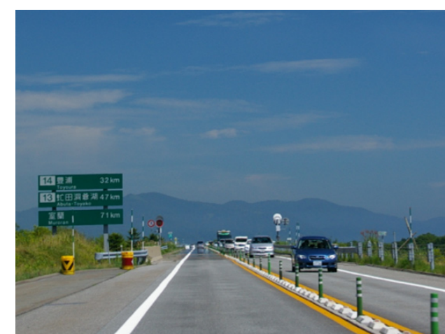
▲高速道路での設置例(日本)
