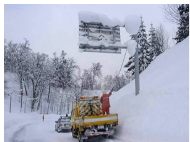
▲標識上部の除雪作業は、危険でコストもかかる作業
