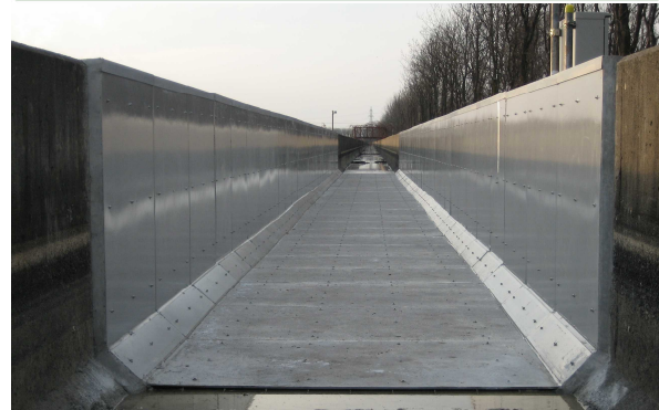
寒地農業用水路の補強に資する水路更生工法
