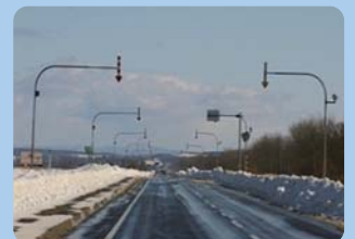
固定式視線誘導柱(矢羽根)
