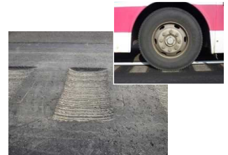
▲ 推奨規格の試験施工状況
