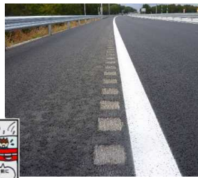
▲ 自専道の路肩に設置された既存規格のランブルストリップス (切削横幅:150mm 深さ:15mm)
