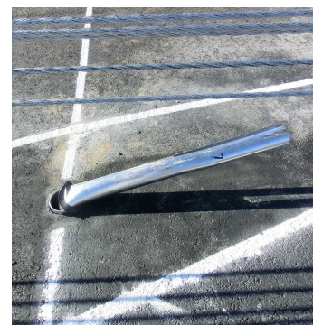
▲破損した支柱を取り外し、スリーブに挿入
