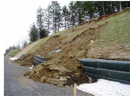
凍上に起因する春先の切土のり面崩壊
