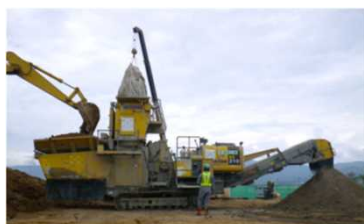
移動式プラントによる改良
