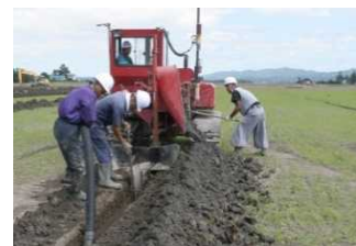
トレンチ掘削による改良
