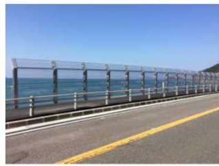
平成27年度 国道202号 佐賀県 唐津市
