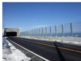
平成28年度 国道336号 北海道 広尾町
