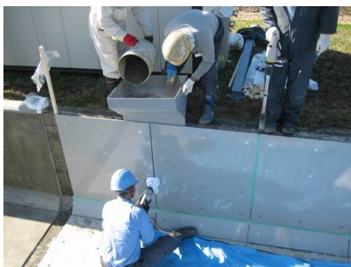
側壁打設状況
