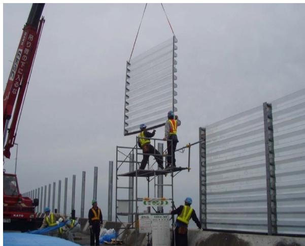
白老バイパス越波柵設置状況
