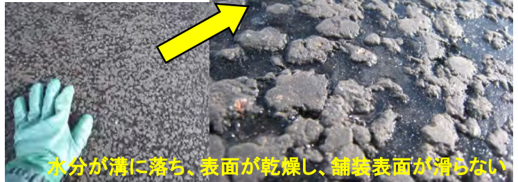
【機能性SMAの舗装表面(凍結時)】
