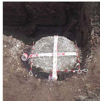
【GCCP出来形確認(改良φ700mm)】 ※株式会社不動産テラのパンフレットより
