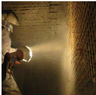
PVA混入モルタル吹付
