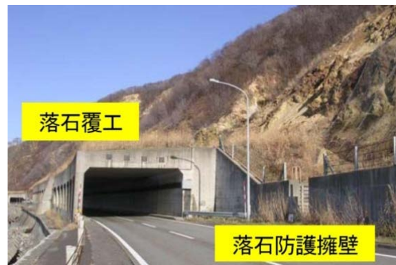
【従来型落石防護工の例】
