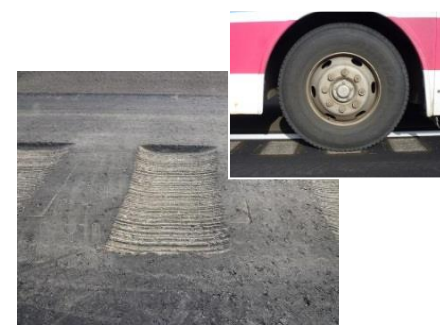
▲ 推奨規格の試験施工状況
