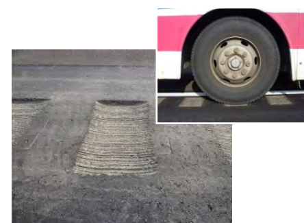
▲ 推奨規格の試験施工状況
