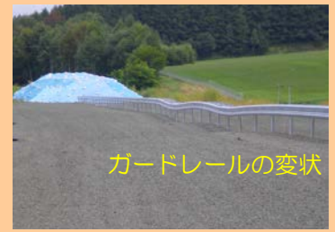
路面の沈下
