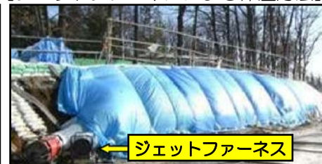
【ジェットファーンネスによる保温方法】
