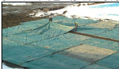
【シートによる雪の混入防止対策】
