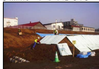
【断熱材による凍結対策】
