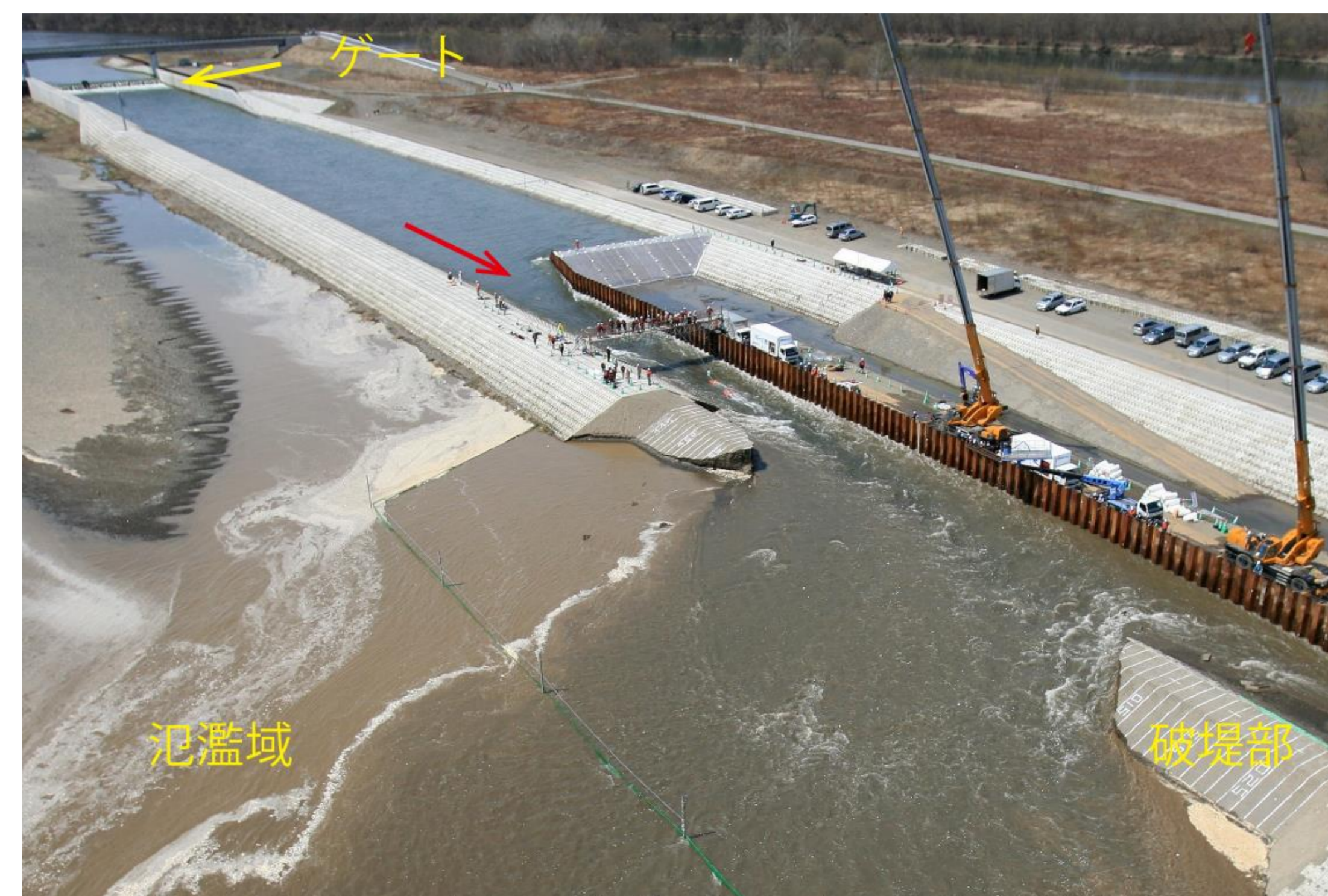
実物大破堤実験の状況
