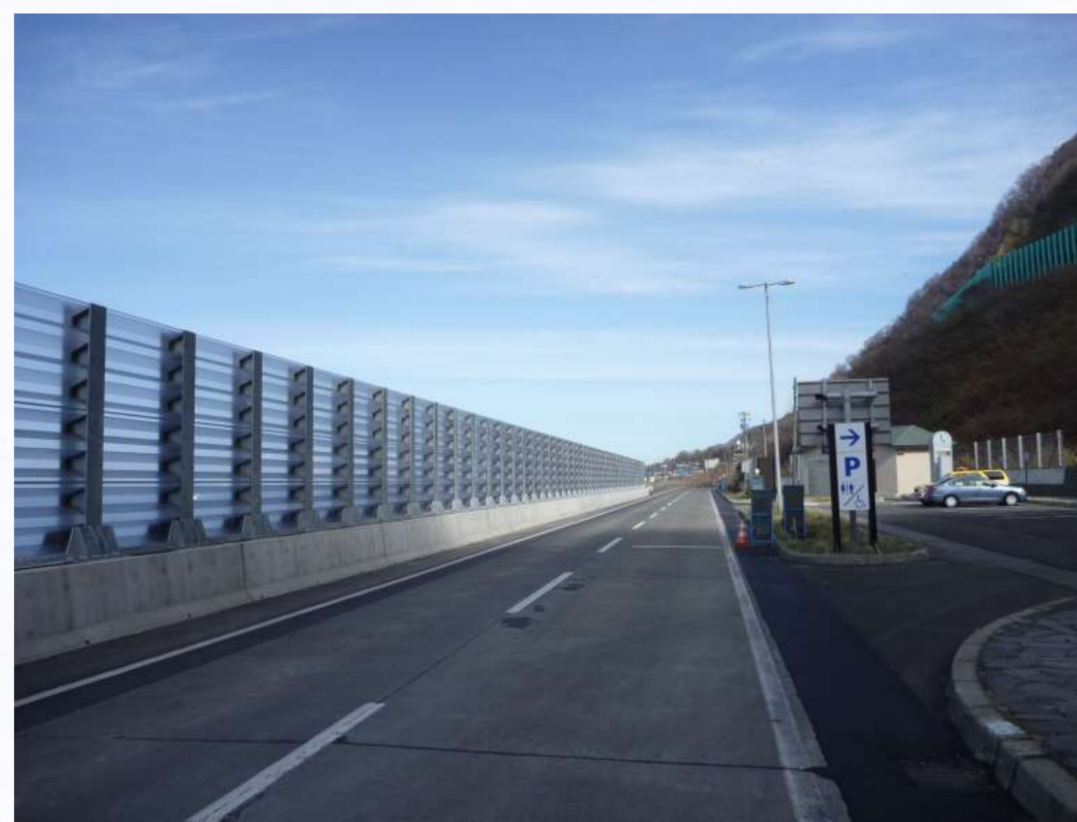
平成23年度防波フェンス設置
