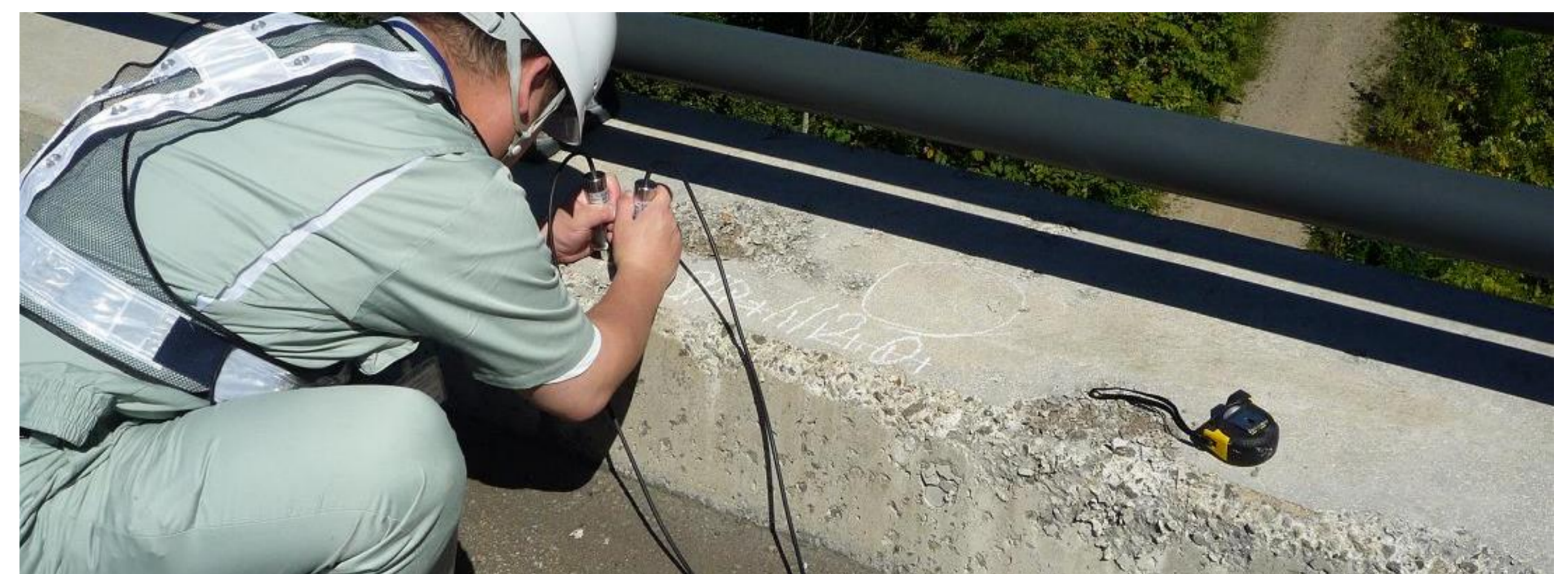
写真-1 点検状況(道路橋) 測定点数は8点/箇所
