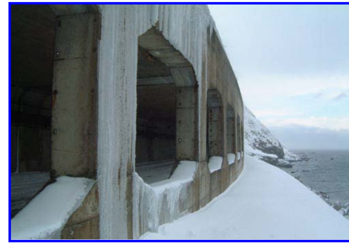
写真(左) 表面が雪水で覆われた日本海沿岸の覆道 写真(右) 凍結防止剤の散布状況(内陸でも塩害が懸念される)
