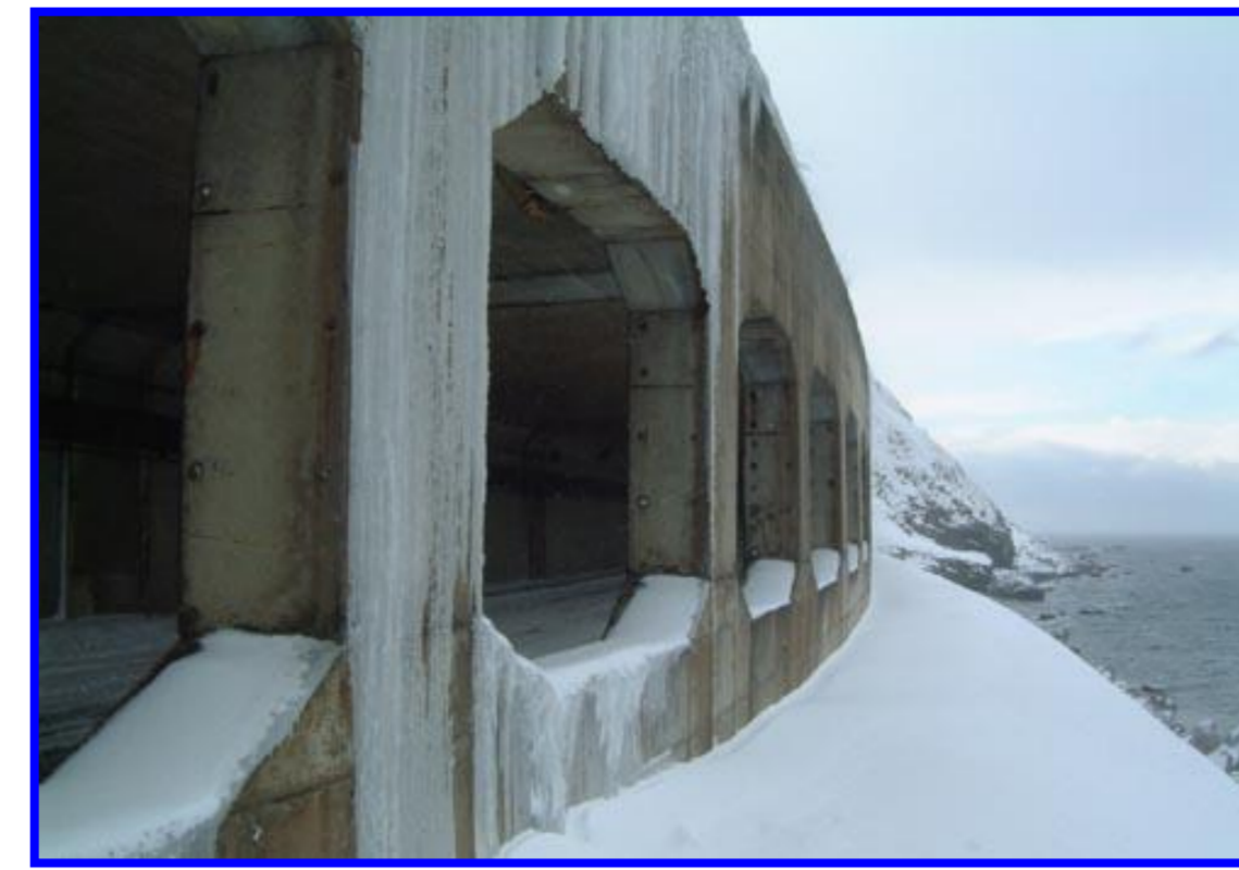
写真(左) 表面が雪氷で覆われた日本海沿岸の覆道 写真(右) 凍結防止剤の散布状況(内陸でも塩害が懸念される)
