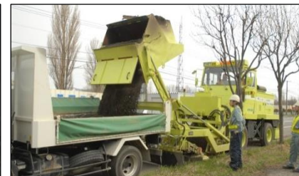
ダンプトラックへの積み込み状況
