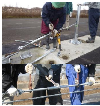
▲索端金具とターンバックルを装着し、張力を調整する。
