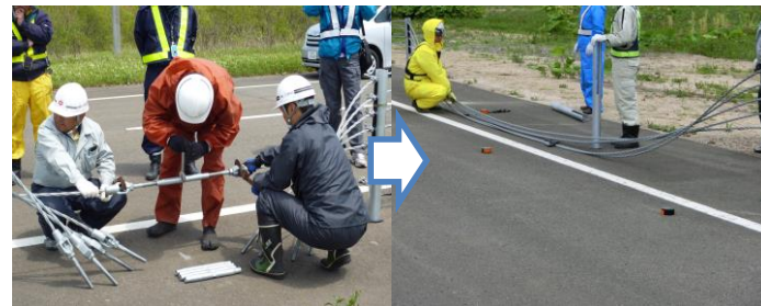
▲支柱は人力で脱着し、開口部を設置
