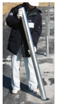
▲破損した支柱を取り外し、スリーブに挿入
