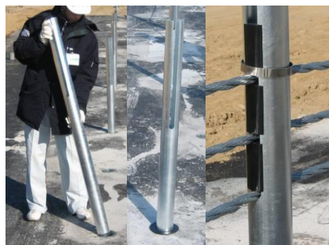
▲支柱を建込み、ワイヤロープと間隔保持材を取り付ける。
