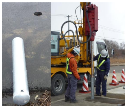
▲舗装にスリーブを打ち込む。
